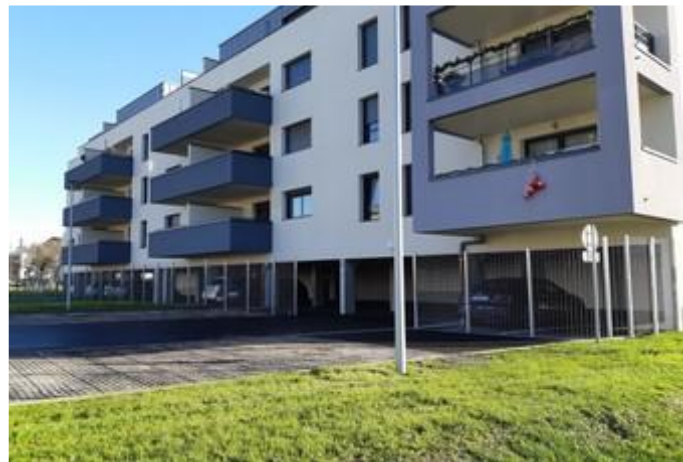
Construction de logements résilients (RDC laissant circuler l'eau en cas d'inondation), Le Ban Saint-Martin Source : AERM
