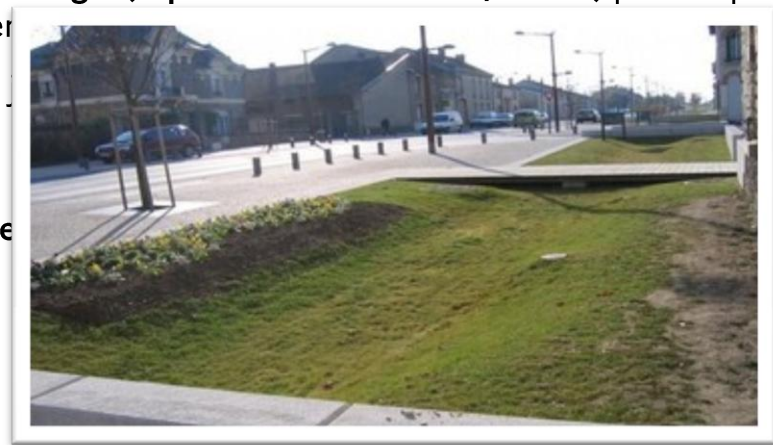
Noue végétalisée permettant de stocker et d'infiltrer l'eau de pluie, Witry-les-Reims. Source : AESN
