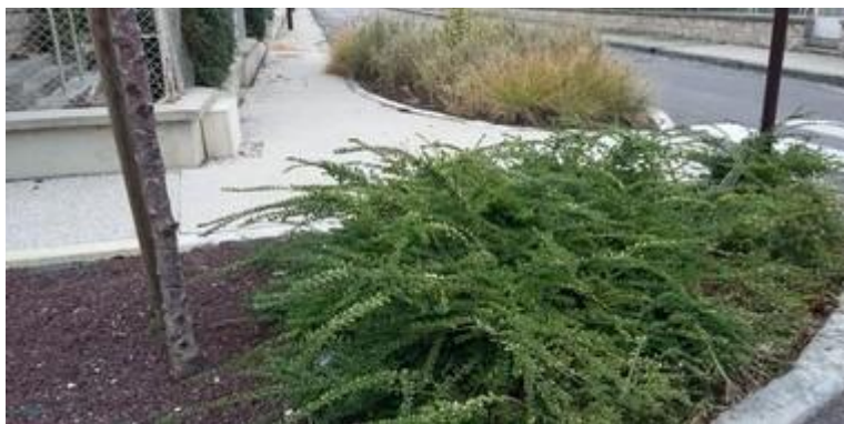
Aménagement permettant l'infiltration de l'eau de pluie, Brienne le Château. Source : AESN
