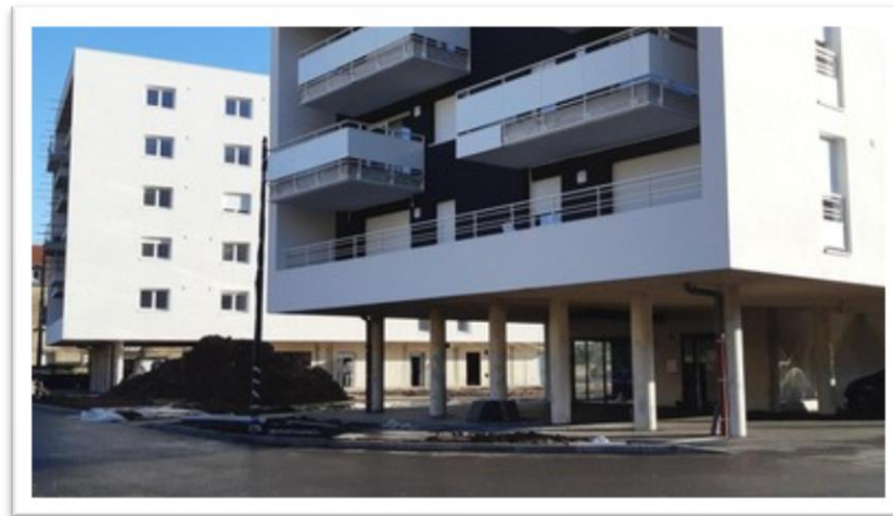
Bâtiments adaptés au risque Le-Ban-Saint-Martin Source : AERM
