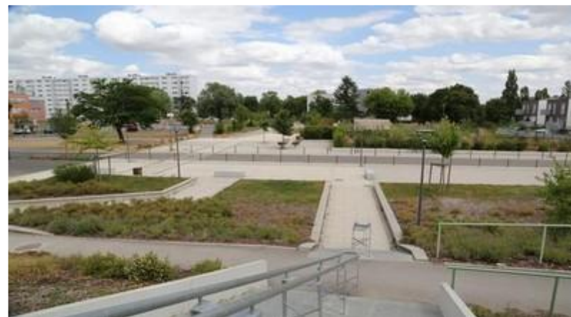
Aménagements végétalisés permettant l'infiltration de l'eau de pluie, quartier Californie, Jarville. Source : AERM
