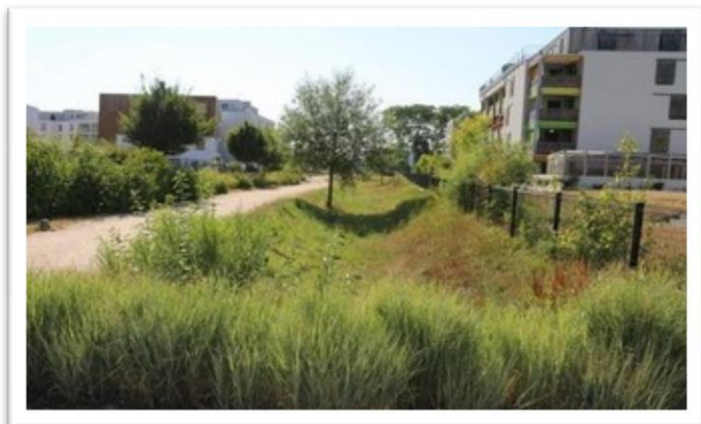
Noüe végétalisée, lotissement Sainte-Anne, Strasbourg. Source : AERM
