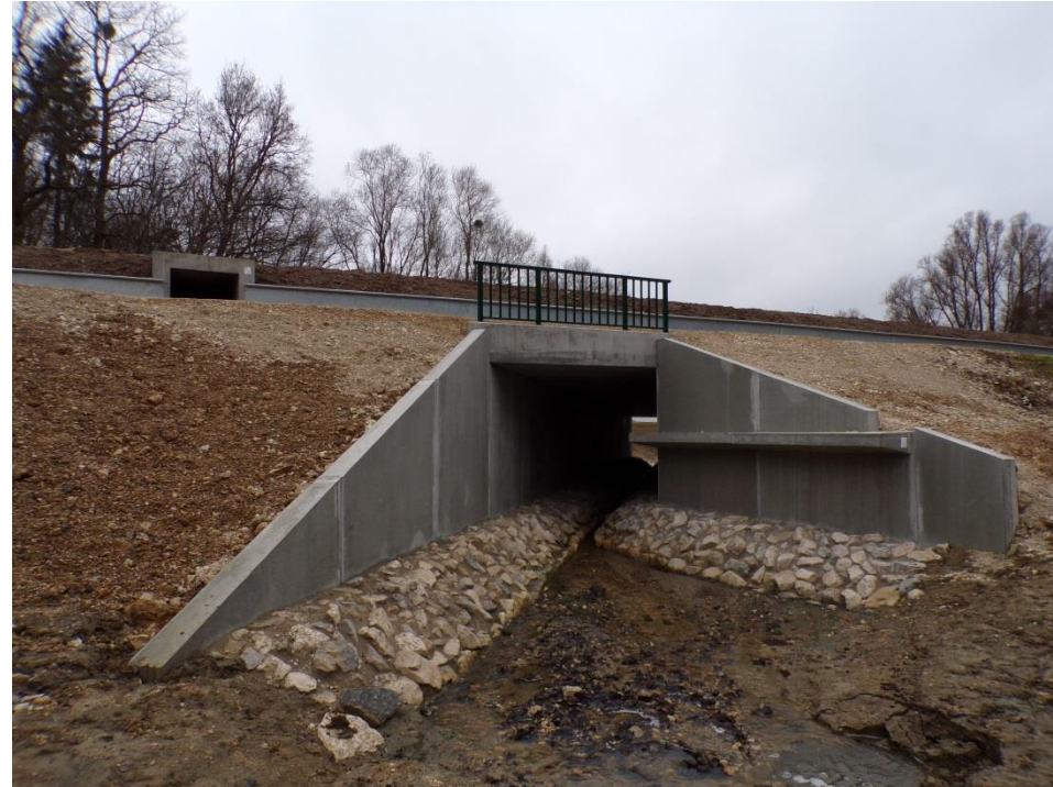
Photo de l'ouvrage, prise de vue amont (février 2022)
