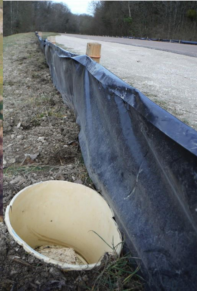
Dispositifs de sauvegarde des amphibiens vis à vis du trafic routier avant aménagements
