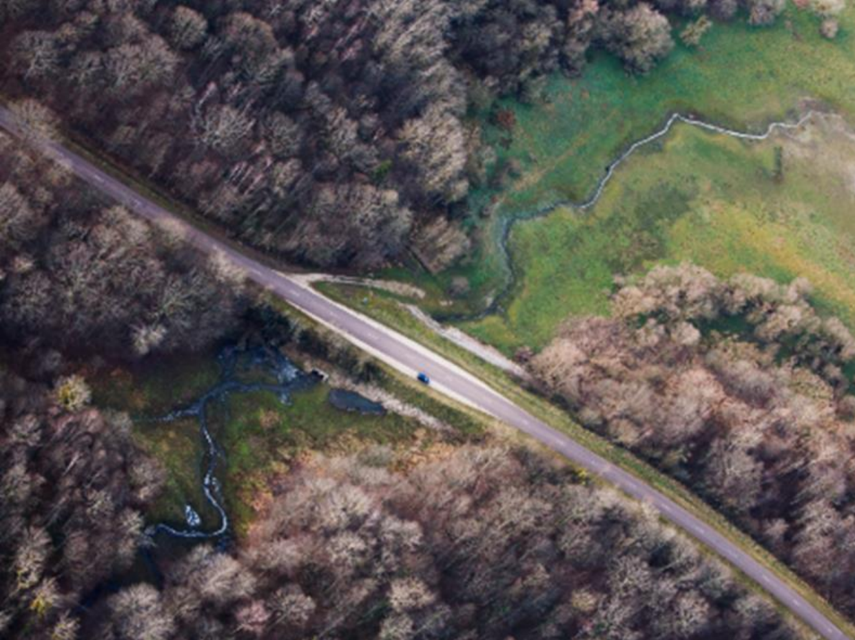
Vue aérienne du site (basses eaux) RD 43 au droit de la Fontaine Colette
