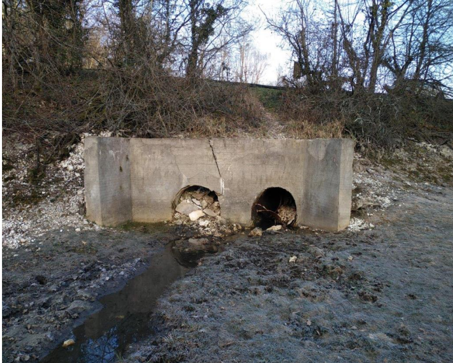
Photo de l'ouvrage, prise de vue amont (mars 2021)
