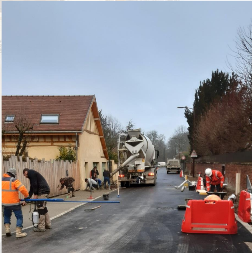
Mise en place du béton drainant
