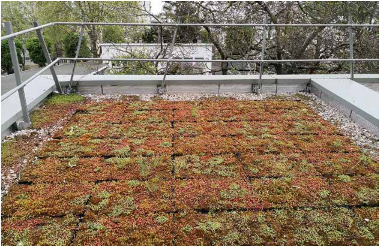
Les toitures végétalisées sont souvent proposées sous la forme de végétaux conditionnés en site de production. Une analyse de cycle de vie (ACV) pourrait s'avérer nécessaire pour évaluer leur impact global. © Marc Barra | ARB idF
