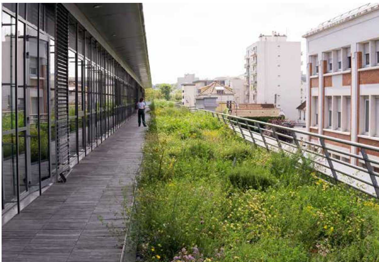
Toiture végétalisée réalisée par Topager sur le siège de GTM Bâtiment à Nanterre © Audrey Muratet | ARB idF
