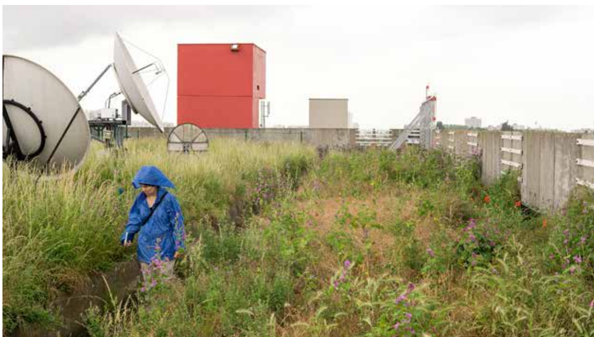
Les conditions climatiques et hydriques influencent la capacité de rafraîchissement des toitures végétalisées. Bâtiment logistique dit « Mozinor » à Montreuil © Audrey Muratet | ARB îdF
