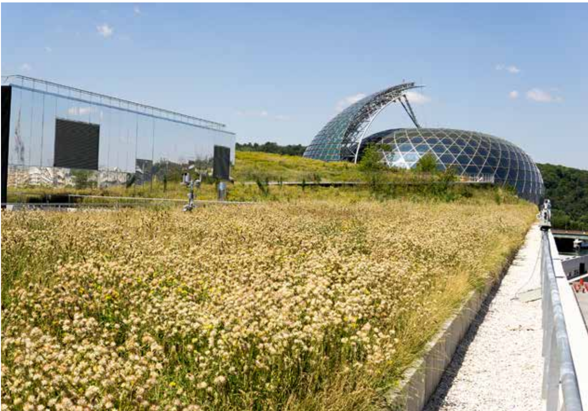
La toiture de la Seine musicale à Boulogne-Billancourt a une capacité de rétention en eau d'environ 184 L/m 2 © Audrey Muratet | ARB îdF
