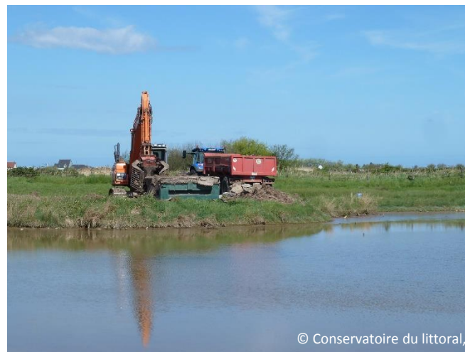
Démolition d'un gabion
