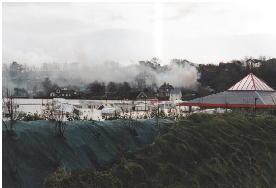
Inondation de la Saône de 1999
