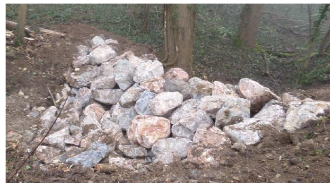
Exemple de réalisation (travaux BV du Voidon)
